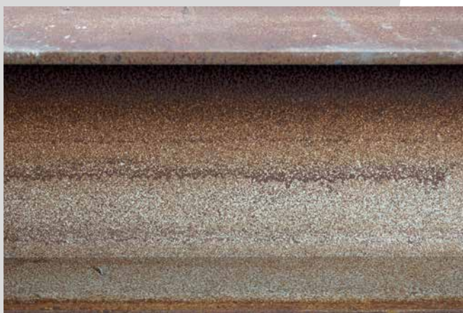
Poutre en acier avant...
